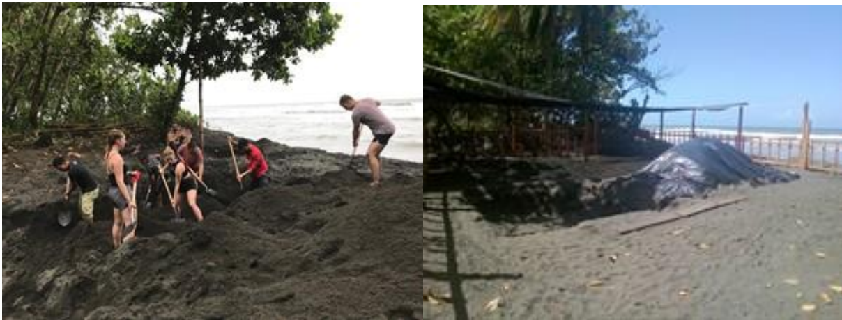
Figura 6. Limpieza de la arena en la zona destinada a la construcción del vivero para la relocalización de las nidadas de tortuga marina.
